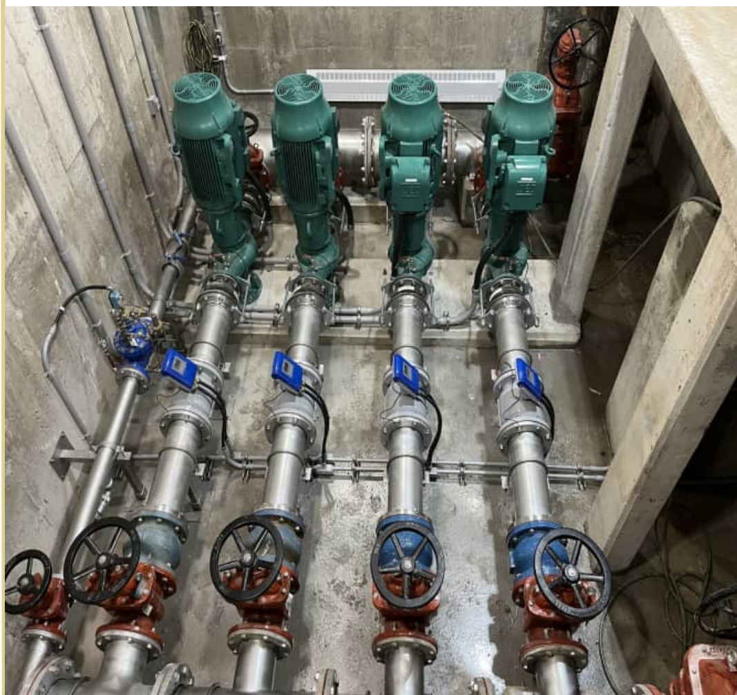
Agencement final , après réfection, des pompes de surpression de la station Côté-Trente
