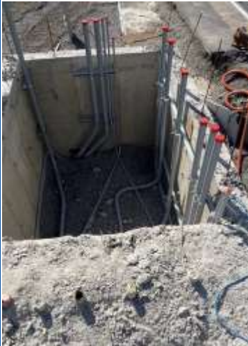
Station Ozias-Leduc—travaux pour recevoir un groupe électrogène permanent
