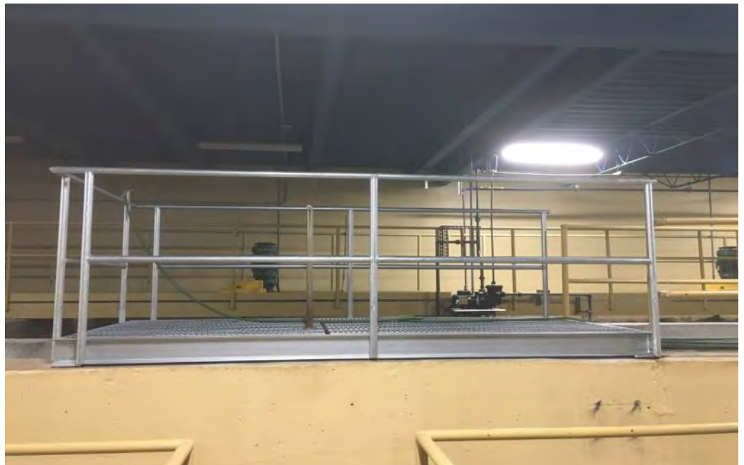
Nouvelles passerelle—décanteur D3
