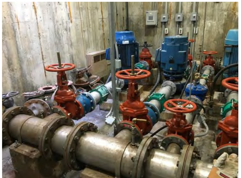
Remplacement des vannes—station Ozias-Leduc
