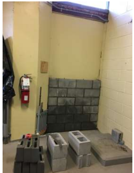
Travaux de maçonnerie—ancienne salle des génératrices
