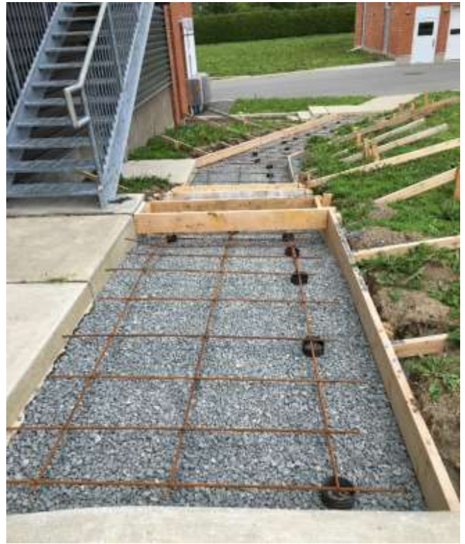
Coffrage pour le trottoir en béton à l'arrière de l'usine
