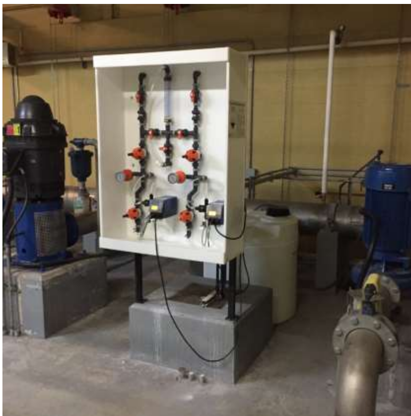
Installation d'un panneau pour les pompes doseuses du réservoir Jackson
