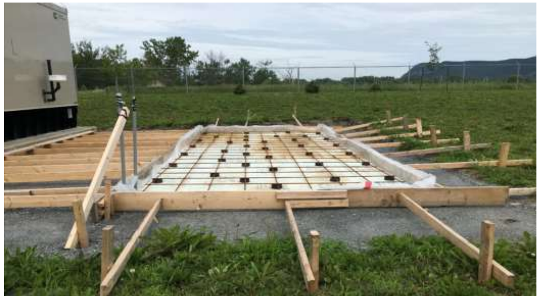
Juin 2020—Coffrage pour la plate-forme du futur cabanon
