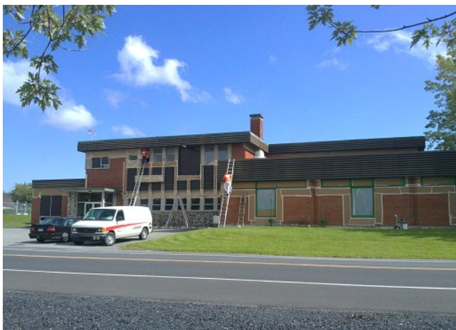
Travaux de peinture du revêtement métallique extérieur
