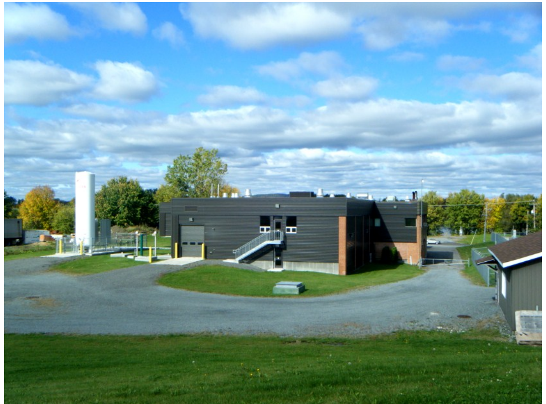
Usine de filtration
